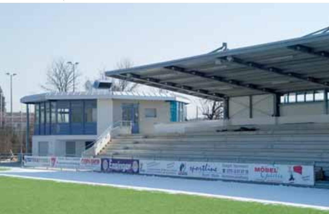
Die Felsenberg-Arena an der Markgröninger Straße kurz vor der endgültigen Fertigstellung von Tribüne, Funktions- und Sanitäräumen im März 2006
