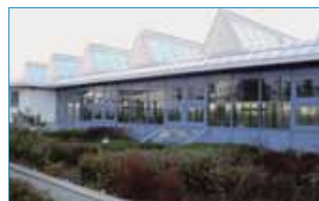
Felsenberghalle, Markgröninger Straße
